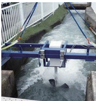
図7 実証試験 Field test
