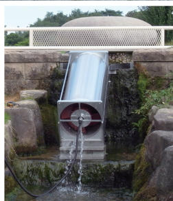
▲近隣の公園に設置したマイクロ水力発電装置 (安全のため通常は右のようにカバーをかけています。本文P6)
