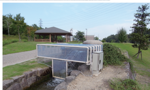
▲近隣の公園に設置したマイクロ水力発電装置 (安全のため通常は右のようにカバーをかけています。本文P6)
