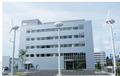
▼先端技術研究所と風力発電機
