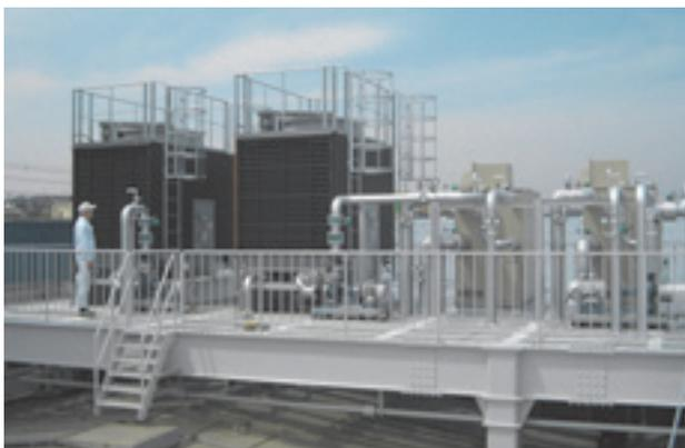
図7 (金剛) 空調システム用ターボ冷凍機・冷却塔
