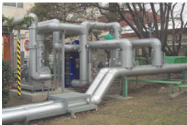
図4 (磐田) 温排水パイプラインと熱交換器
