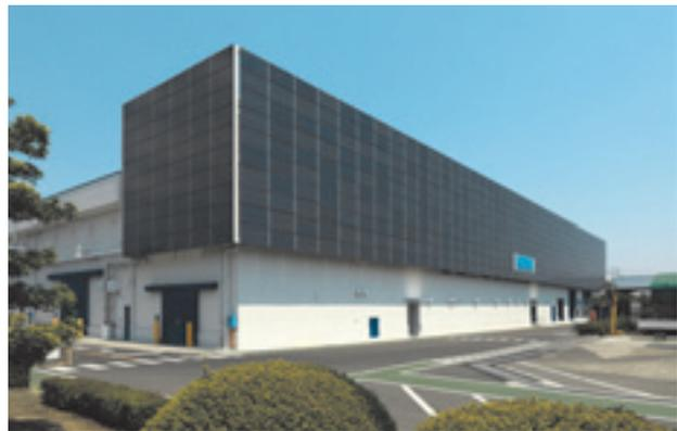
図11 桑名製作所の太陽光発電システム
