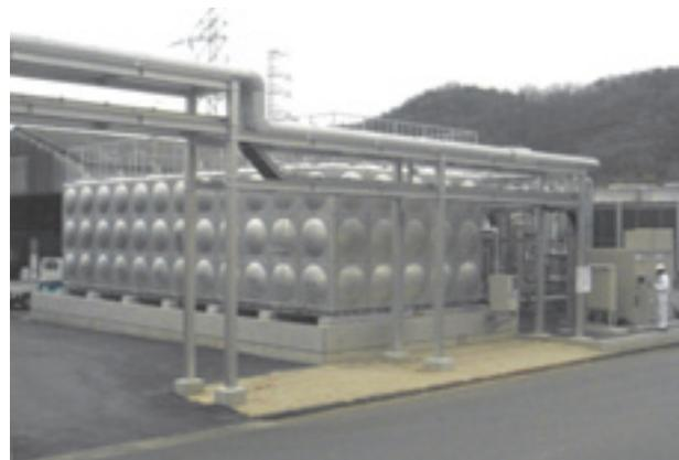
図6 (岡山) 空調システム用蓄熱槽
