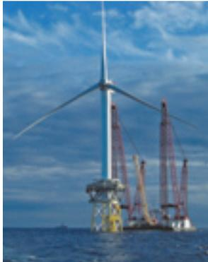
図2 スコットランド北部Beatriceに建設中の洋上風力発電機
