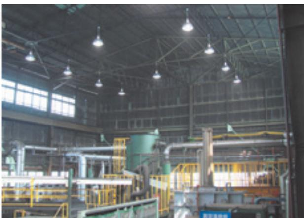
図8 (桑名) 熱処理工場のメタルハライドランプ
