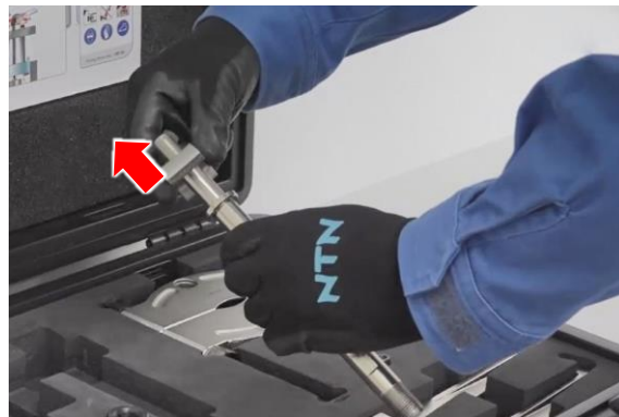
図 5.26 フランジの取外し
