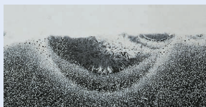
電食発生部の断面
