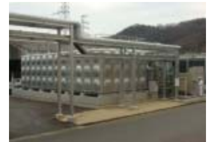
岡山製作所に導入した 「水和物スラリー蓄熱空調システム」
