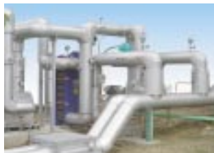
温排水の廃熱利用設備
