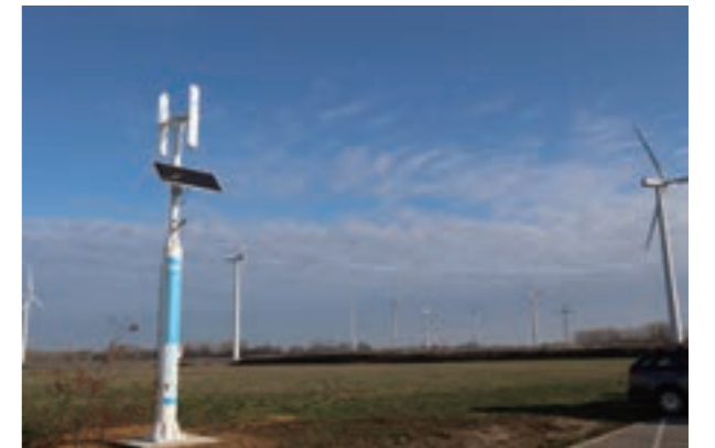
NTN-AT内に設置されたNTNグリーンパワーステーション(手前)と電力会社の風力発電装置
