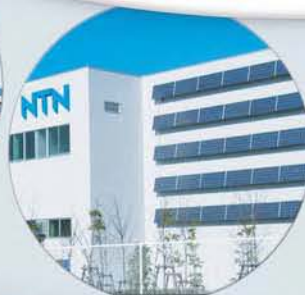
(株)NTN三重製作所第二工場の太陽光発電機 発電量:102MWh/年 CO 2 削減量:約46トン/年
