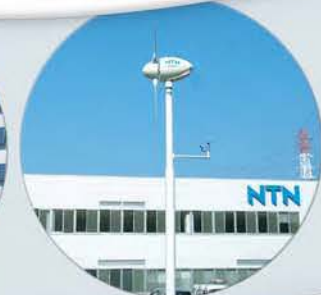
(株)NTN袋井製作所の風力発電機 発電量:7MWh/年 CO 2 削減量:約3トン/年
