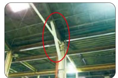
岡山製作所の耐震工事例
