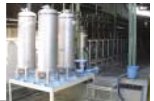
雨水等の熱処理冷却水への再利用
