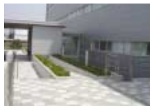
廃メディア(砥石)を用いた歩道ブロック
