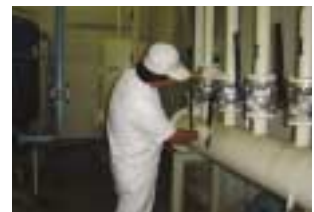
エア漏れチェック
