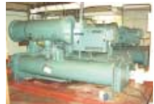
冷却用チラーユニット
