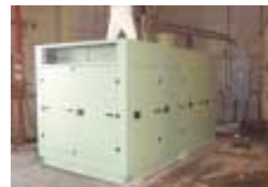
可変速スクロールコンプレッサ
