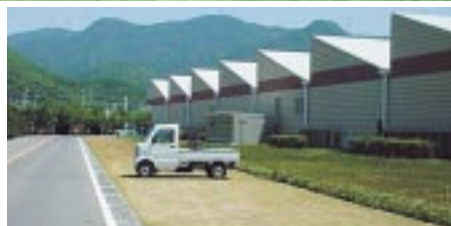
耐圧芝舗装駐車場
