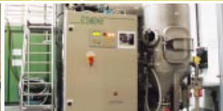
油水分離装置
