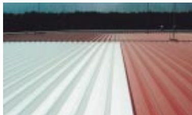
遮熱塗装(白い部分)
