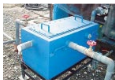
地下水浄化装置
