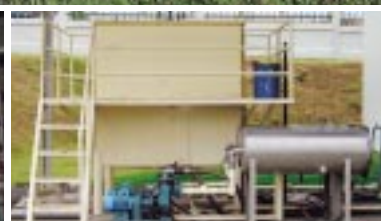
廃水処理装置
