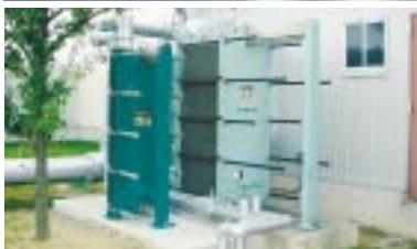
コージェネ排熱利用のための熱交換器
