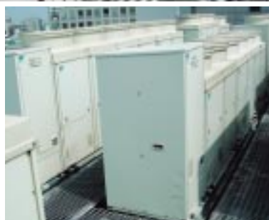
氷蓄熱式空調システム
