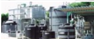
排水処理施設
