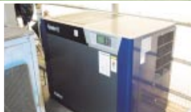
インバータ付コンプレッサ 75kW
