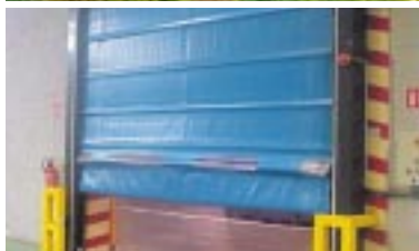
自動開閉式シャッター
