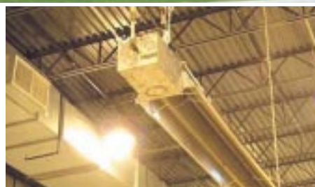
作業場所の上に取り付けられた輻射型ヒーター
