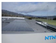
太陽光パネル
