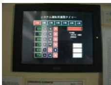
コンプレッサの台数制御盤
