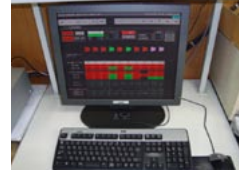
エアコンプレッサの制御用パソコン
