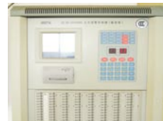
消防管理システム
