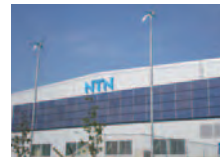
第三工場の太陽光発電システム
