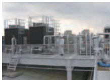
空調用ターボ冷凍機・冷却塔
