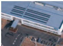
太陽光と風力発電機
