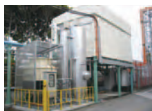
高効率新設コンプレッサ
