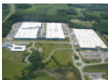
遮熱塗装を施した屋根
