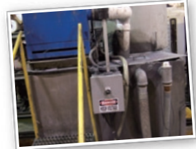
▲ 排水遠心分離式の濾過装置
