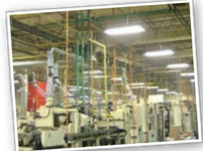
▲ 工場内高効率蛍光灯
