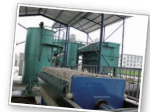
▲ 廃水処理設備
