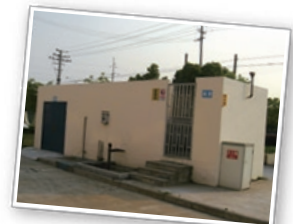
▲ 新規油倉庫の設置
