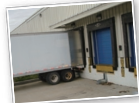
▲ トラックドックの改善 (外気を遮断し暖房の熱を逃さない)
