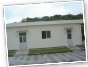
▲ 廃水処理装置
