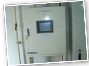
▲ コンプレッサのコントローラ
