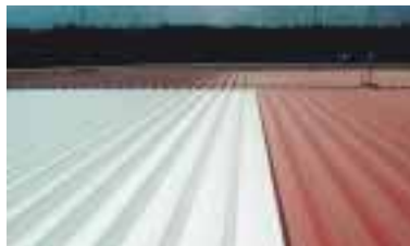
遮熱塗装(白い部分)
