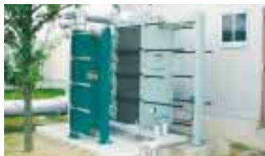
コージェネ排熱利用のための熱交換器
