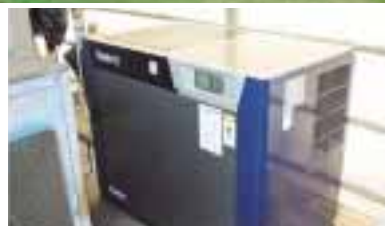
インバータ付コンプレッサ 75kW
