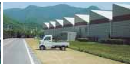
耐圧芝舗装駐車場
