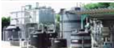
排水処理施設
