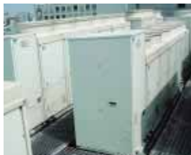
氷蓄熱式空調システム
