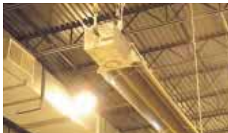
作業場所の上に取り付けられた輻射型ヒーター
