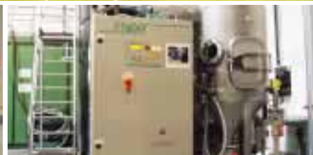
油水分離装置
