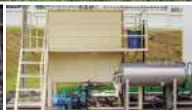
廃水処理装置
