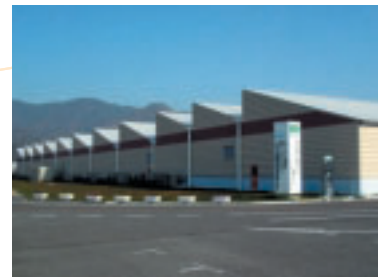
岡山製作所内新工場：アクスルユニット専用工場 （2005年1月27日竣工式開催）
